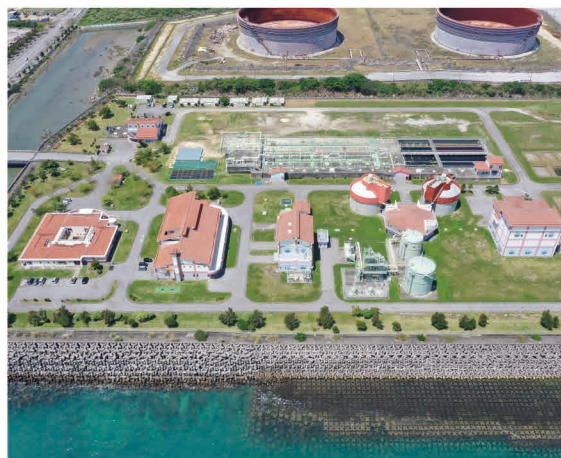
西原浄化センター(みずクリン西原)
