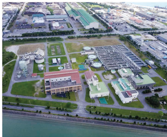
具志川浄化センター(みずクリン具志川)
