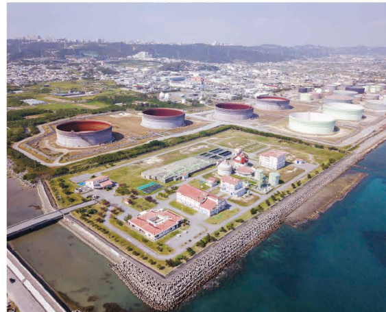
西原浄化センター(みずクリン西原)
