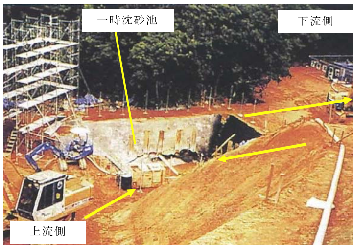
一時沈砂池の完成イメージ
