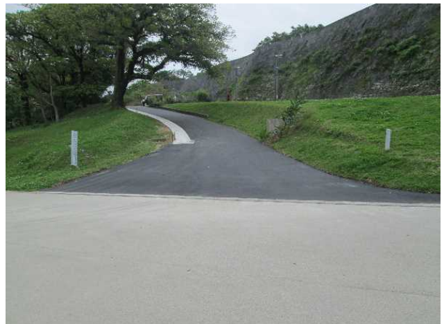
コンクリート張側溝、アスファルト舗装等：西側から撮影
