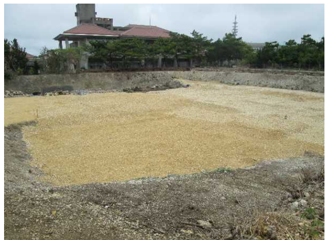
境内における遺構保護工：南西側（史跡首里城跡）から撮影
