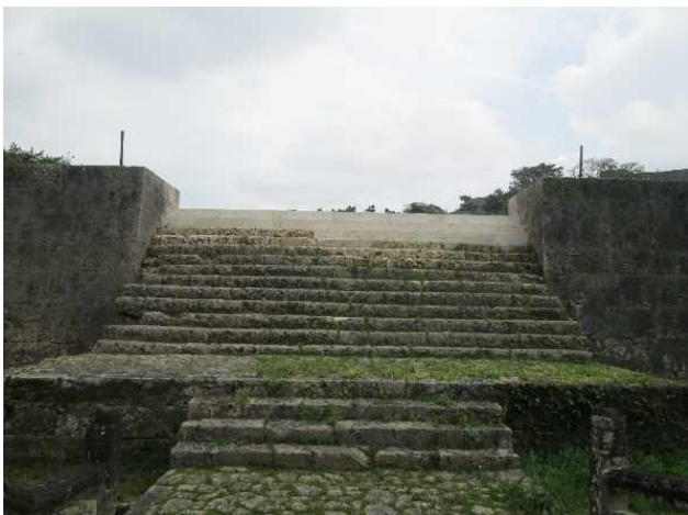
石階段修復後：総門の裏側から撮影
