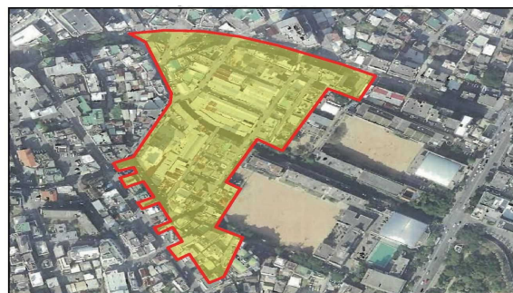
工事着手前（平成 21 年頃）
