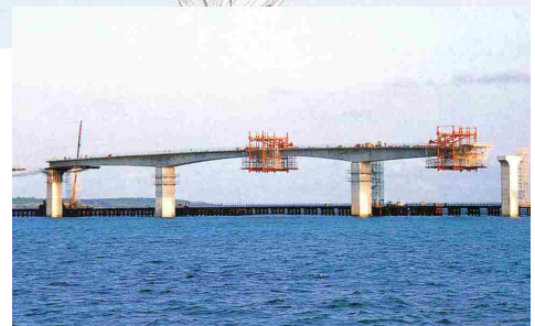
航路部のワーゲンによる施工状況
