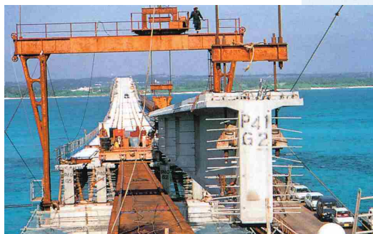
T桁の架設状況
