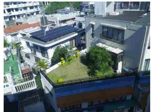
屋上緑化（那覇市内）
