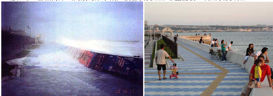
北谷町 宮城海岸（高潮対策事業）被害状況(左)と整備後の利用状況(右)
