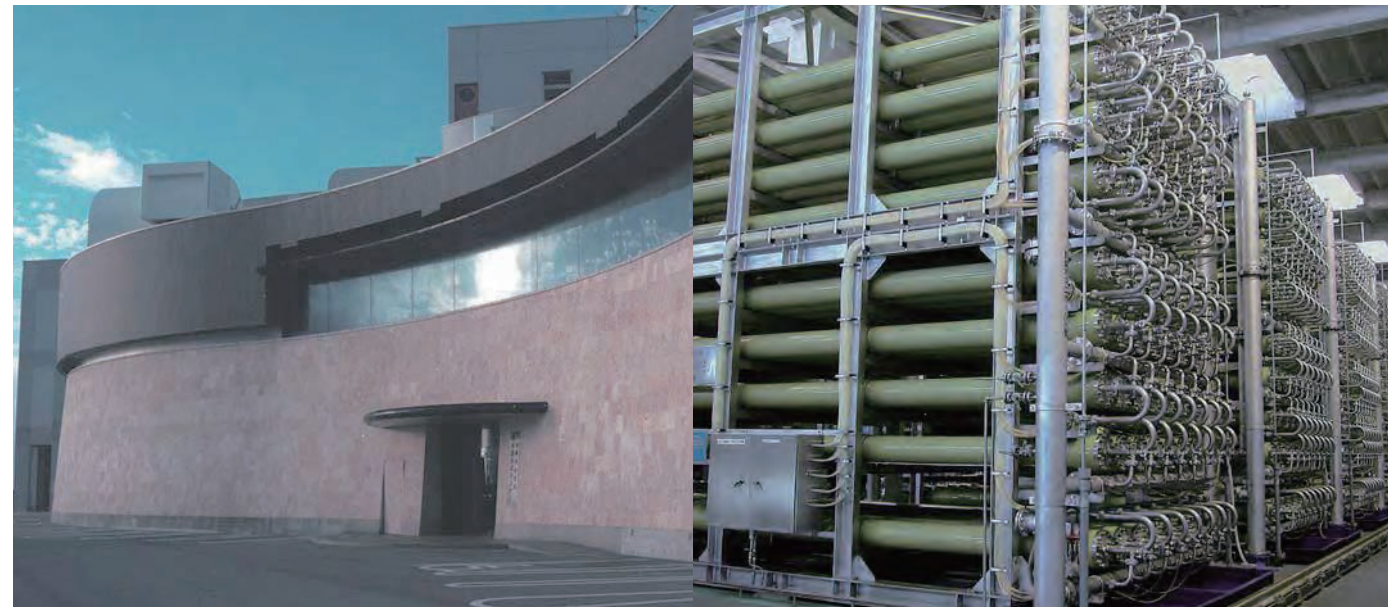
海水淡水化センター (沖縄県企業局)
