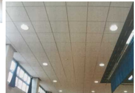
施工後→ 軽量天井(2kg/m 2 以下) 照明設備(落下防止対策)
