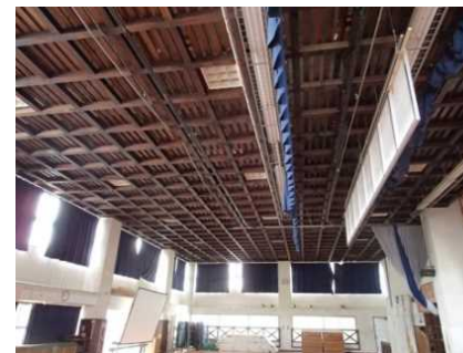
←施工前 既設天井(木製)
