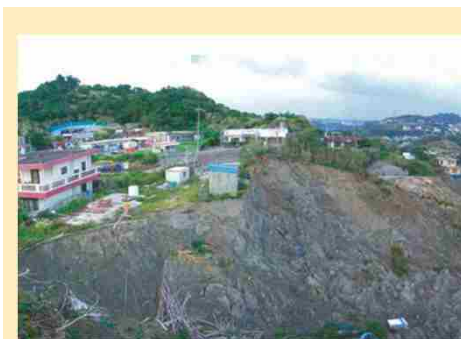
中城村安里地すべり
