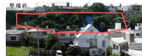
整備前 整備箇所:北中城村島袋地区 整備内容:鉄筋挿入工、法枠工等 総事業費:約4億円 事業期間:平成29年度～令和6年度
