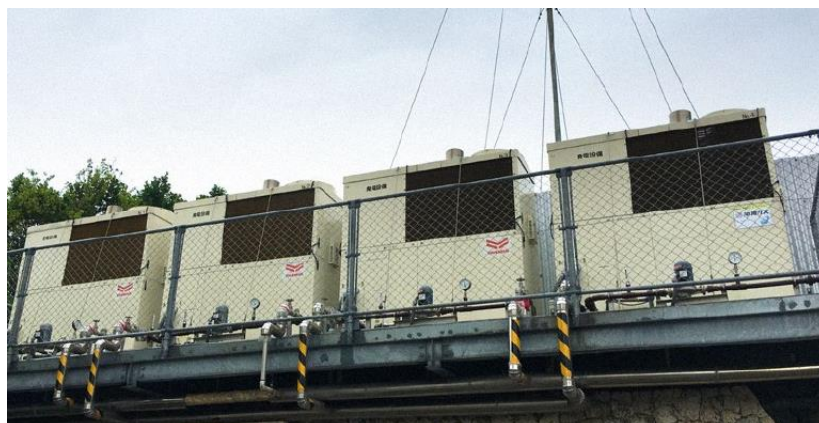
図 4-3 ローザールホテル&スパタワー那覇におけるガスエンジン・コージェネレーション
