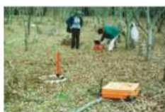
電磁探査実施の状況
