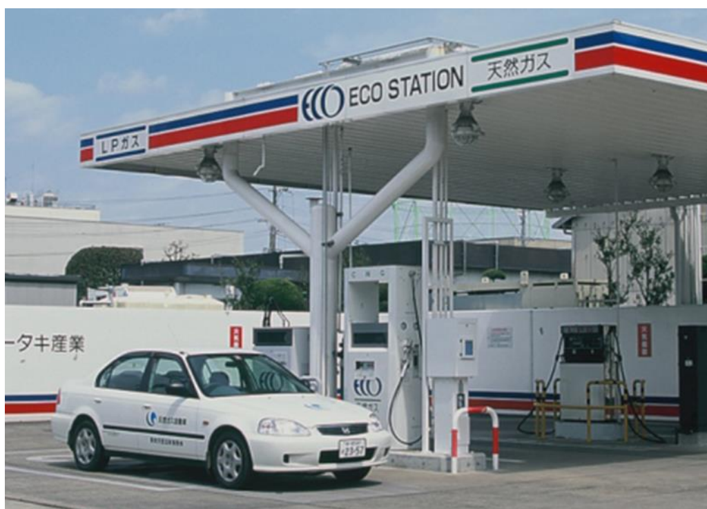
2.3.3 天然ガススタンド全景（千葉県茂原市）
