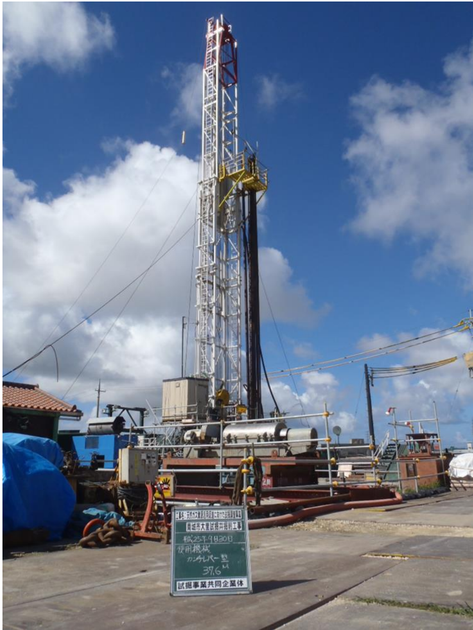
图 2.3 大里 R-1 掘削工事状况
