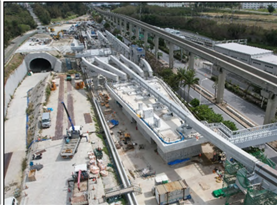
写真 8.45 新車両基地全景（整備中）
