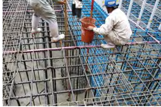
写真 10.6 スポンジで除去している状況
