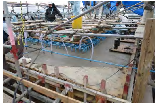
写真 10.8 型枠を支保工で固定している状況
