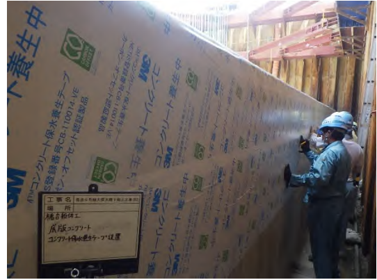
写真 8.39 A1 フーチング養生シート貼付状況
