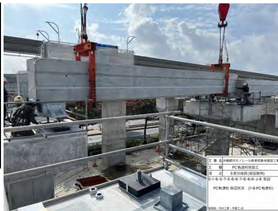
写真 8.46 架設状況（PC 軌道桁）
