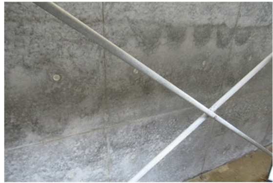
写真 10.3 バイブレータ過挿入による模様
