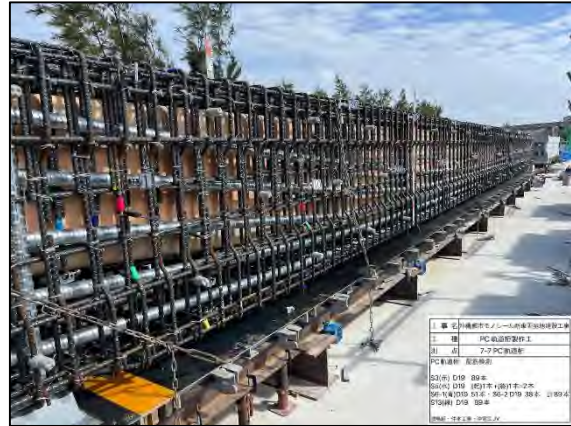
写真 8.47 鉄筋組立状況
