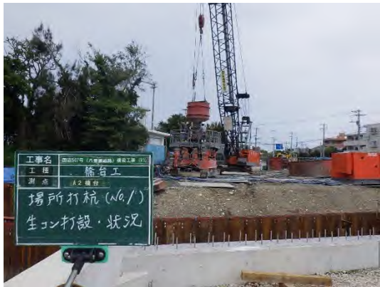
写真 8.41 場所打ち杭打設状況
