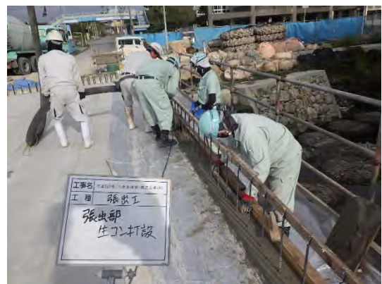
写真 8.44 張出部打設状況
