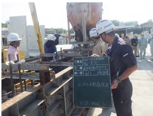
写真 8.43 上部工主桁打設状況
