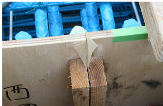
写真 10.9 ノロ漏れ防止テープを型枠両側に貼り付けた状況
