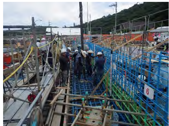
写真 8.37 A1 橋台打設状況
