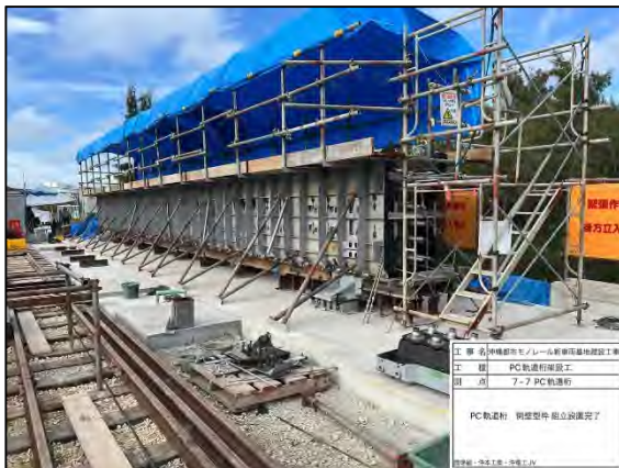
写真 8.48 型枠組立状況
