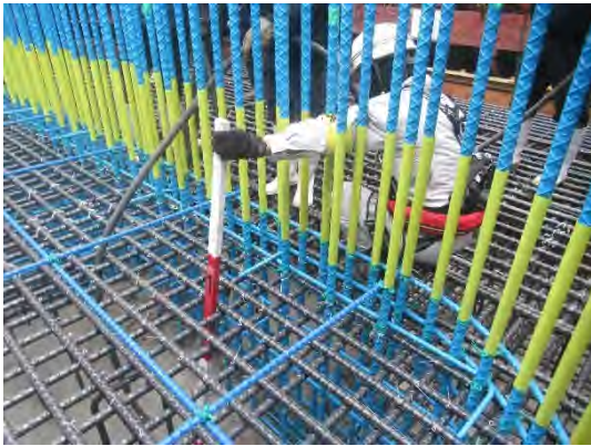
写真 8.40 P1 橋脚フーチング打設状況
