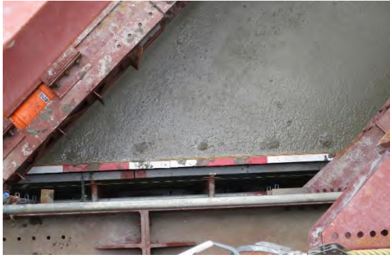
写真 10.2 型枠天端のマーキング
