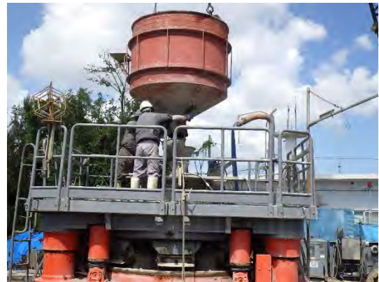
写真 8.41 場所打ち杭打設状況
