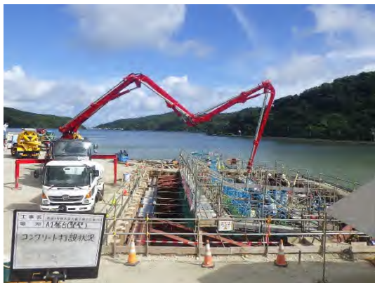
写真 8.37 A1 橋台打設状況
