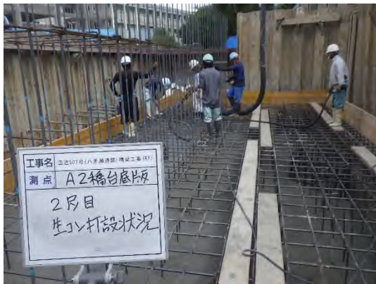
写真 8.42 A2 橋台打設状況
