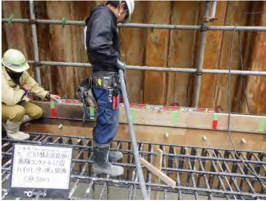
写真 8.38 A1 橋台フーチング打設
