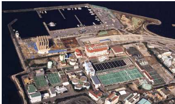
処理施設 | 下水終末処理場 (那覇浄化センター)
