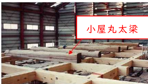
前回復元時の正殿 小屋丸太梁 (オキナワウラジロガシ) 写真：沖縄総合事務局 国営沖縄記念公園事務所
