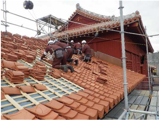
被災した奉神門屋根の復旧工事
