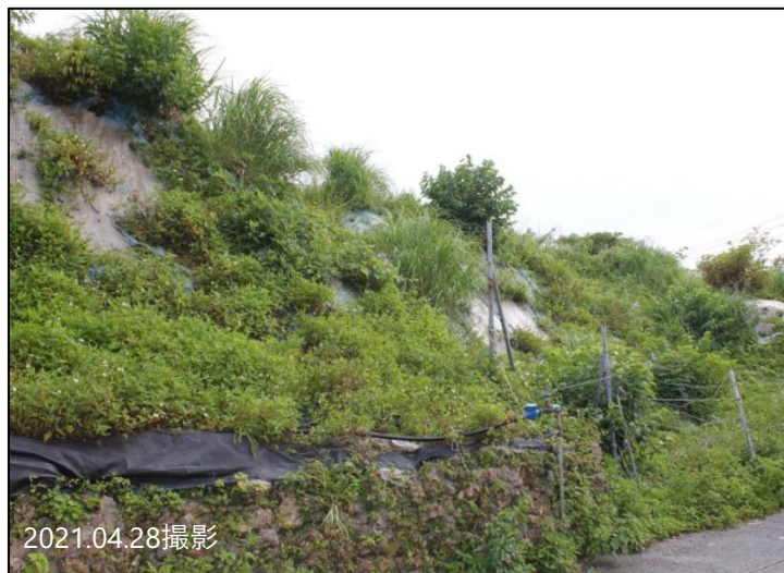
上之御殿エリア北側斜面地
