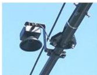
図 3-11 超音波式車両感知器
