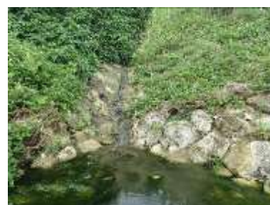
場外排水路上流呑み口 (平成 27 年 10 月)
