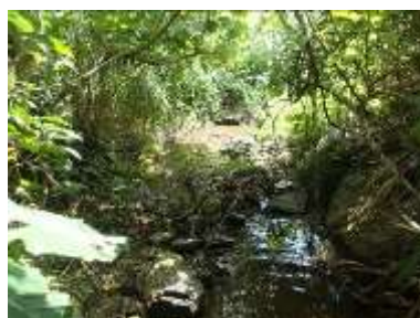
個体を確認したボックスカルバート上流側(平成 28 年 3 月)
