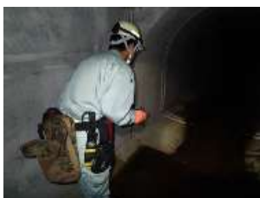
カルバート内踏査
