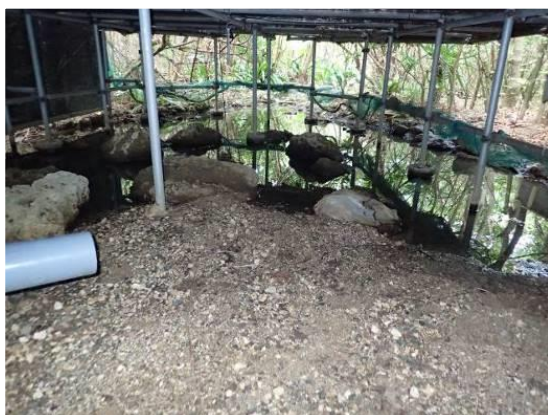
写真2 上流からワンドA内に流入した土砂(左)と流入した土砂の撤去状況
