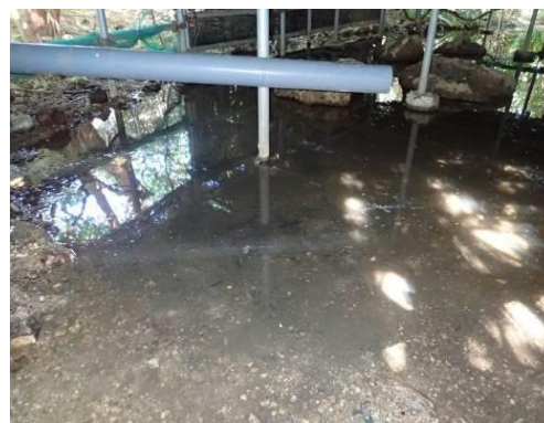
土砂撤去後の状況 (12/18)
