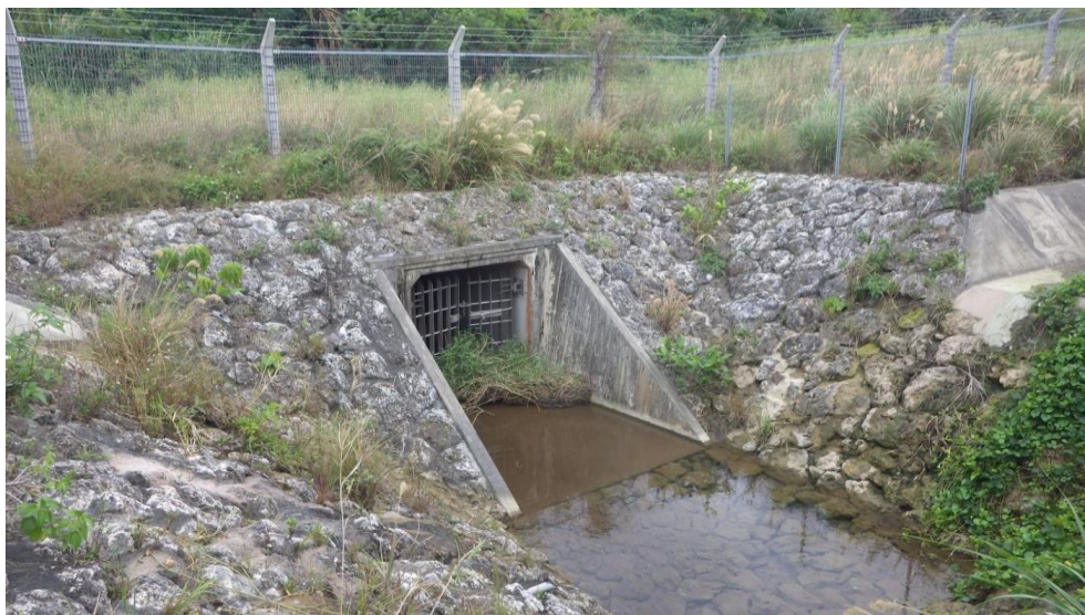
図 5.47 ボックスカルバート西側入り口 (撮影：平成 26 年 1 月 16 日)
