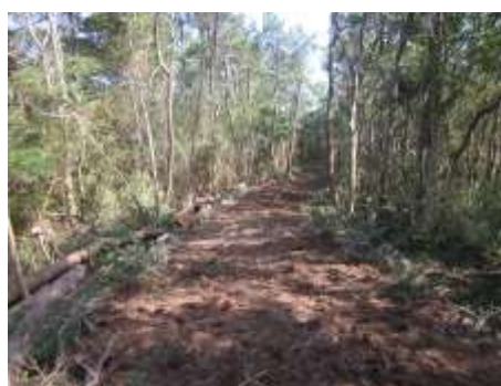
環境に配慮した作業道（国頭村）
