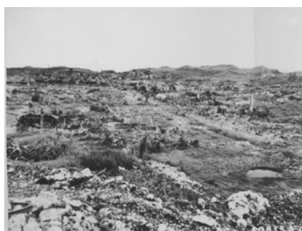
戦争により破壊しつくされた県土 (1947年)
