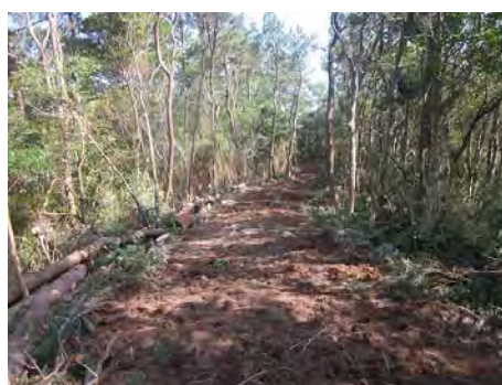
環境に配慮した作業道（国頭村）
