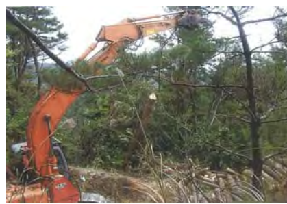
H19 帯状択伐実証試験 (スイングヤーダによる収穫)
