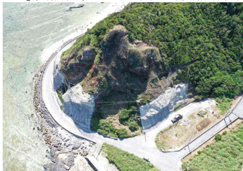
落石防護工、モルタル吹付工
