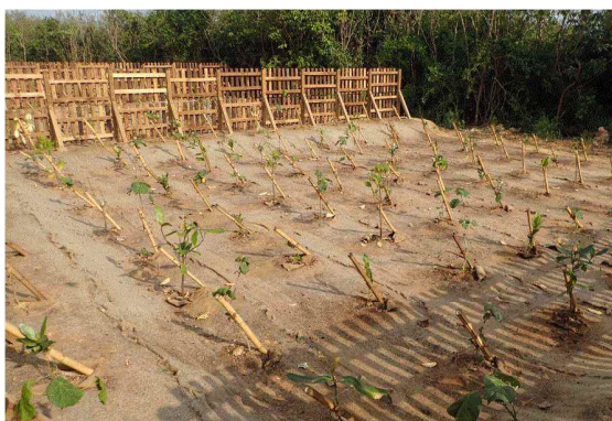
植栽工、防風工
