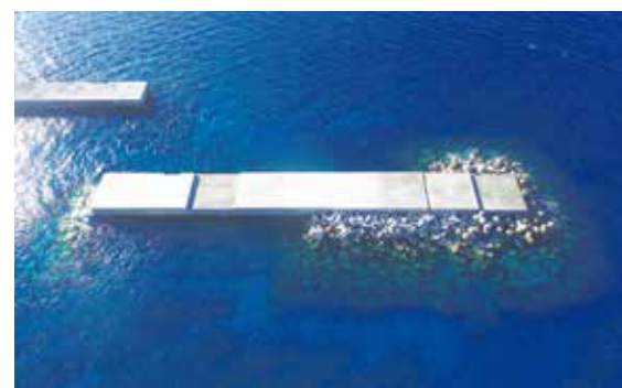
▼防波堤の整備
