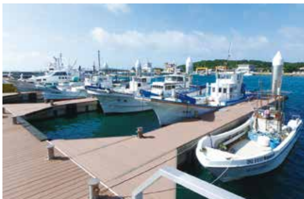
▼浮桟橋の整備
