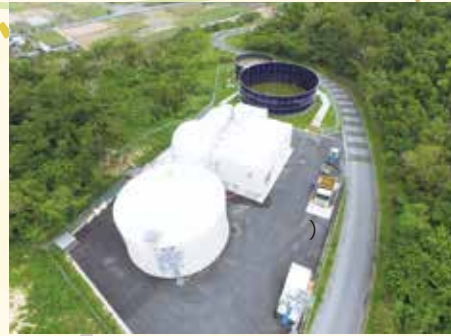
▼バイオガスプラント（八重瀬町）
