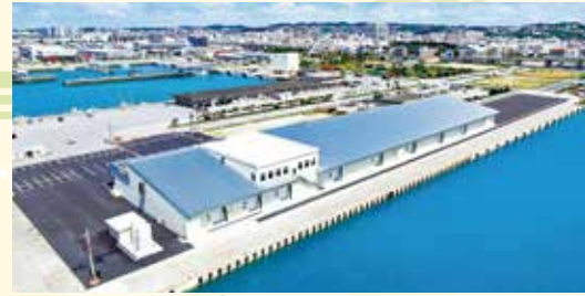
▼高度衛生管理型荷捌施設（イマイユ市場）
