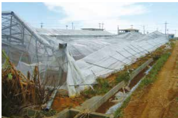
▼園芸施設の台風被害
