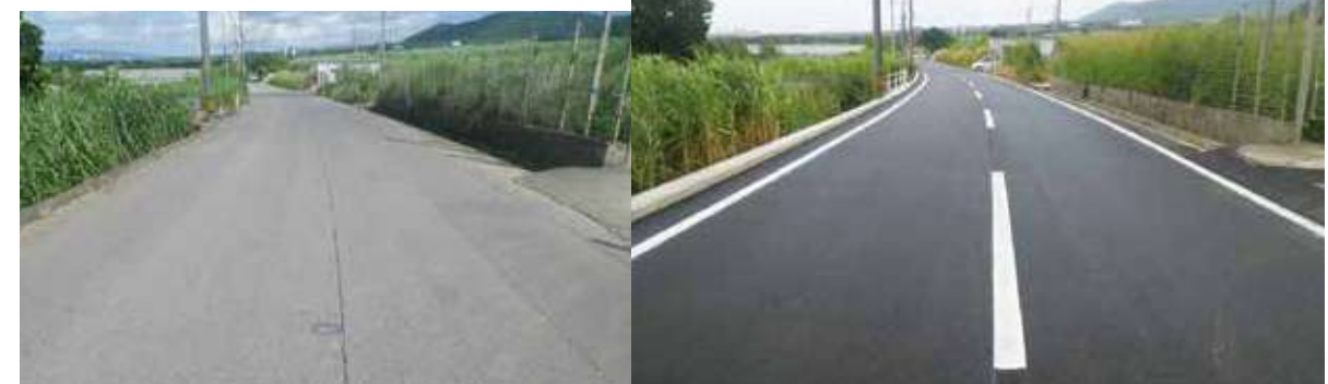
▼農道の機能保全対策（左 / 施工前→右 / 施工後）
