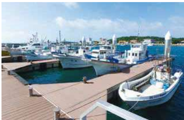
▼浮桟橋の整備
