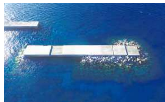
▼防波堤の整備
