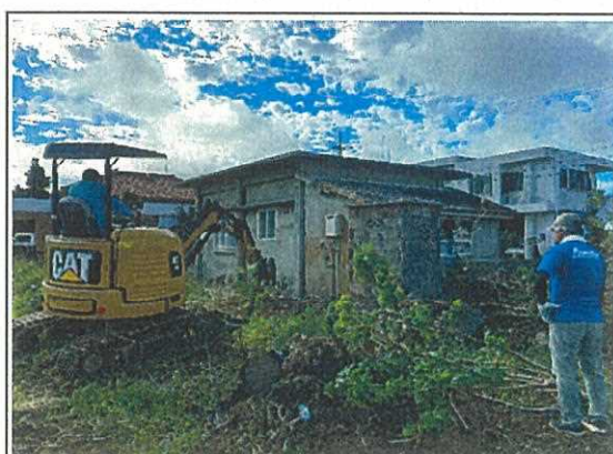
住宅裏敷地整備作業（12月）
