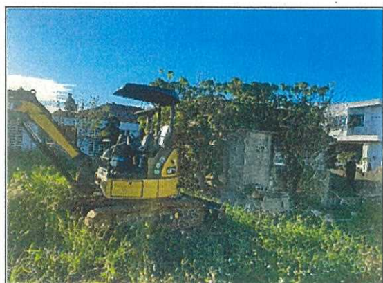
住宅裏敷地（作業前）
