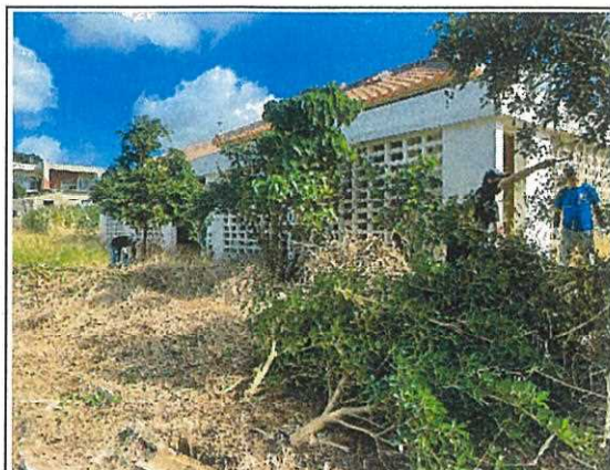
住宅敷地東側作業（12月）
