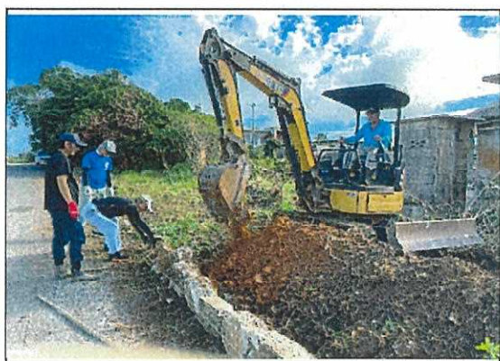
住宅敷地西側境界線作業（12月）
