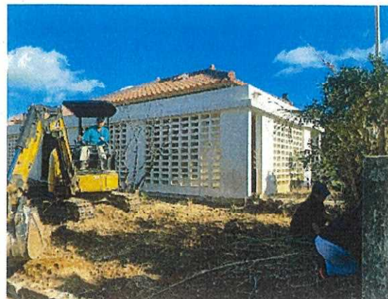
住宅敷地東側整備作業（12月）
