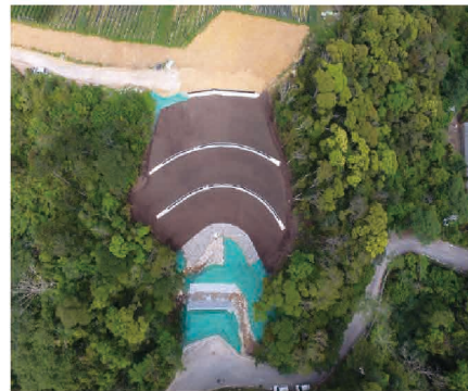
真喜屋地区(名護市、土砂崩壊防止工)
