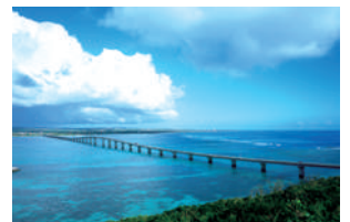
⑥宮古島市【伊良部大橋】
