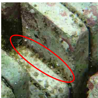
図 2.2.2-12 基盤に付着した藻類と 基盤の隙間に詰まった 貝類の糞
