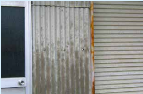
石綿スレート（屋根・外壁）
