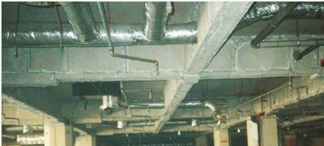
耐火被覆用石綿含有ケイ酸カルシウム板（2種）（S造の柱・梁）
