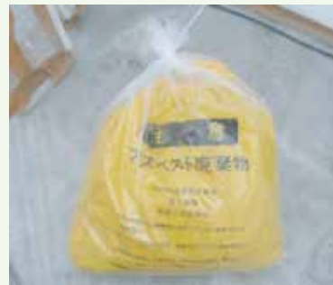
アスベスト廃棄物の二重袋詰
