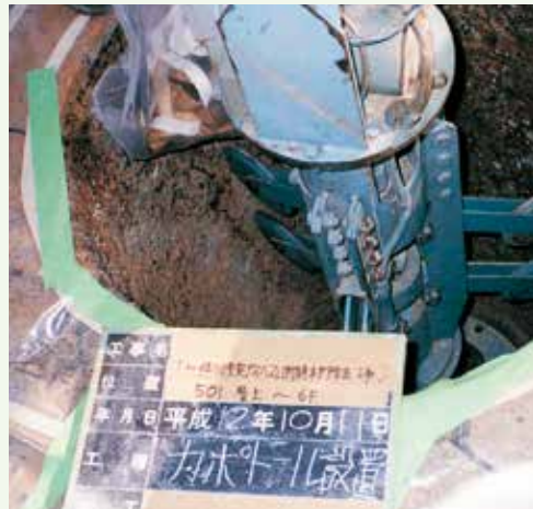
乾式除去の専用機械
