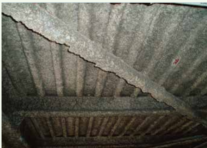
断熱用吹付け石綿・石綿含有吹付けロックウール（折版屋根裏、デッキプレート床裏、階段裏・庇裏等）
