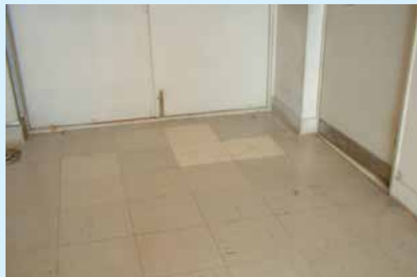
石綿含有ビニール床タイル（床）
