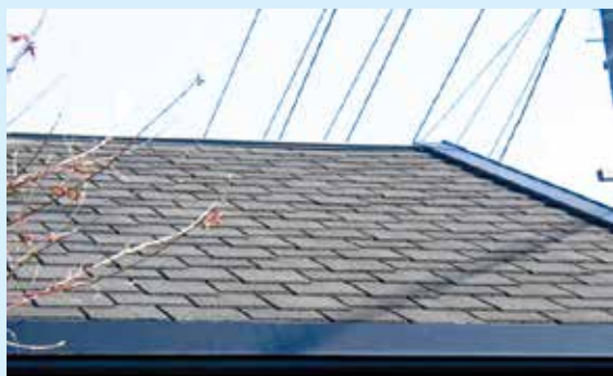
石綿含有住宅化粧用スレート（屋根）
