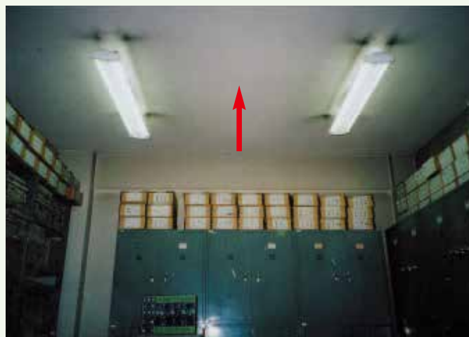
結露防止用の石綿含有バーミキュライト吹付け・パーライト吹付け（天井・壁等）
