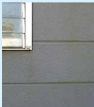
石綿板（窯業系サイディング）
