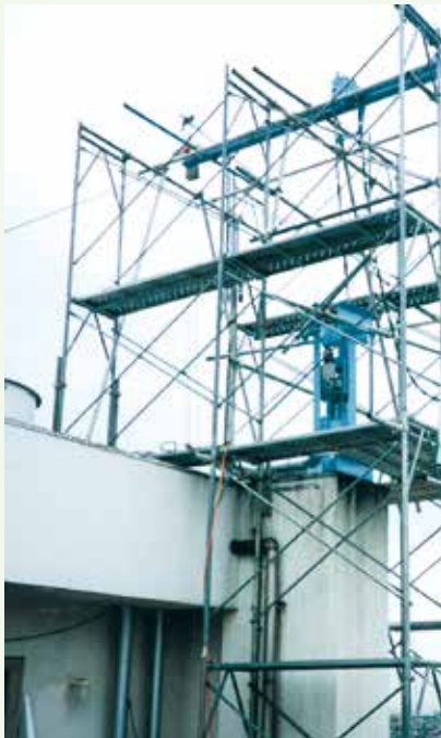
煙突上部及び灰出し口を隔離養生
