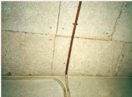
木毛セメント板 (打ち込み)
