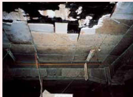
発泡ポリスチレン (打ち込み)
