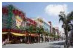
観光施設、 空港港湾等 損壊・浸水
